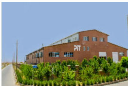
پل ایده آل تجهیز
